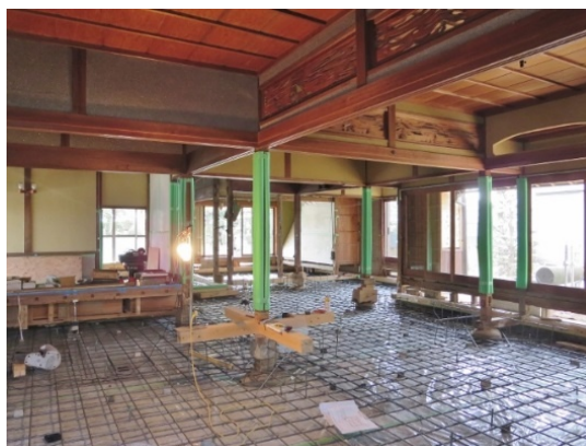
工事中(基礎配筋)
