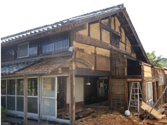
工事中(一部減築のための解体)
