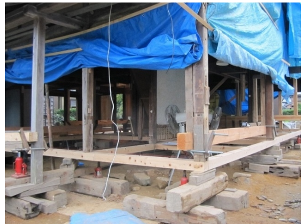
工事中(揚げ家)
